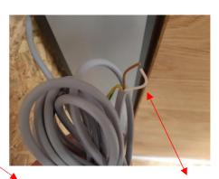
2. Wenn die Minute vorbei ist, nehmen Sie das graue Kabel und verbinden **braun** mit **weiß**, dadurch wird ein Signal (Öffnung über Sprechanlage simuliert) zum A-Öffner gesendet, der die Türe Kurzzeit öffnet. Nach dem Schließen verriegelt sich die Türe wieder automatisch.
